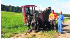
Auf dem Blumberger Berg bei Redoschingen unterquerten die Arbeiter gestern eine Gasleitung der Badenova unter Aufsicht. Ganz rechts Ulrich Rauhut von der Badenova, neben ihm Polier André Weigand von der WeigandBau GmbH. Lutz
