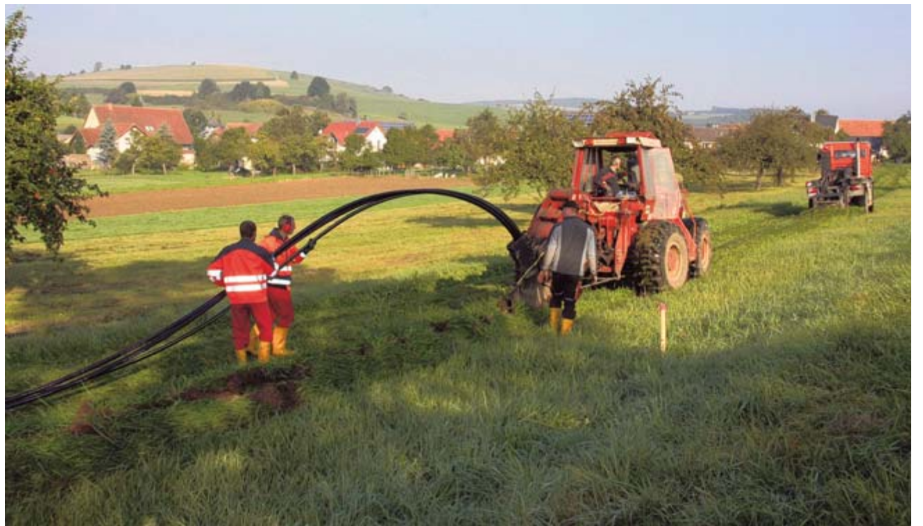
Gestern früh verlegten die Arbeiter der Firma Weigand zunächst das letzte Stück vor Hondingen die Leerrohre mit dem Glasfaserkabel. Vorneweg fährt die Seilwinde, dahinter der Traktor mit dem Pflugschwert. BILDER: LUTZ
