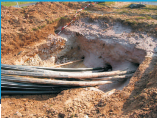
Zielgenaue 3. Pilotbohrung (links) und 2 eingezogene Rohrpakete (2 x 8 Stück Da90 x 8,2 mm KSR) in einer Zielgrube 2 x 2 m (insgesamt 24 Rohre)
